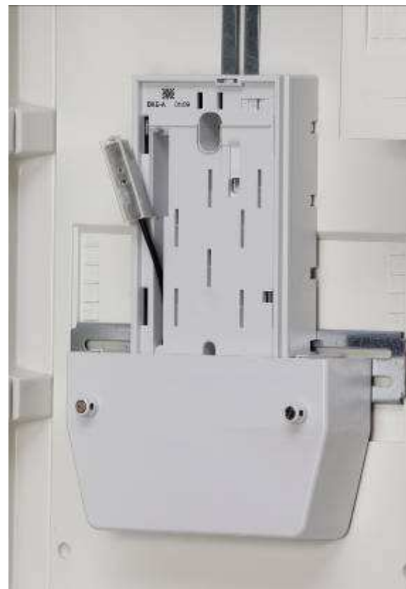
Leitungsführung in den Klemmendeckel
