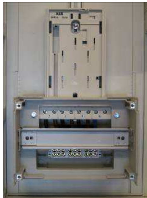
BKE-x - Varianten der BKE-A mit zusätzlichen Hutschienen für Zusatzgeräte
